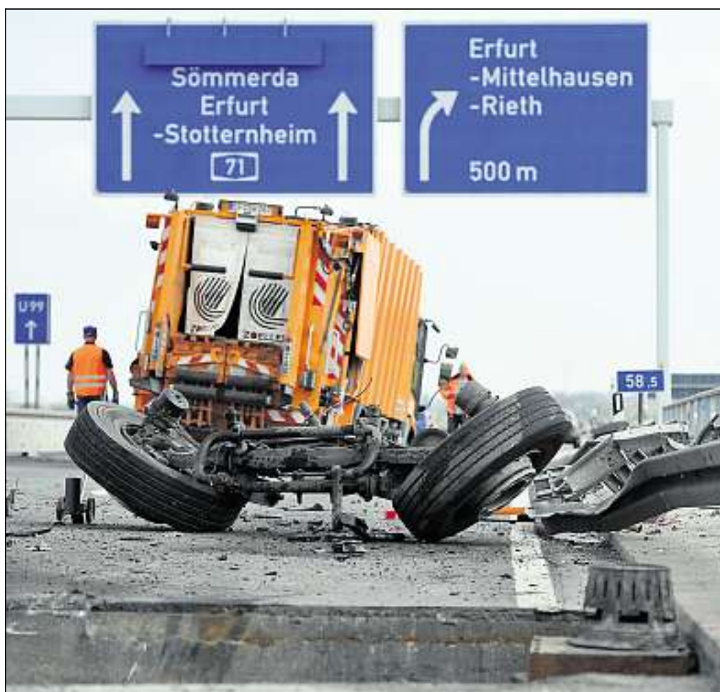
Zum Glück nur Blechschaden: Auf der A71 bei Erfurt ist Mitte April der Fahrer eines Müllautos in eine Baustelle gefahren. Durch ein etwa ein Meter tiefes Loch fuhr der Lastwagen noch hinweg, riss sich dabei die Hinterachse ab. Im darauf folgenden zweiten Loch kam er dann zum Stehen. Foto: Marcus Scheidel
